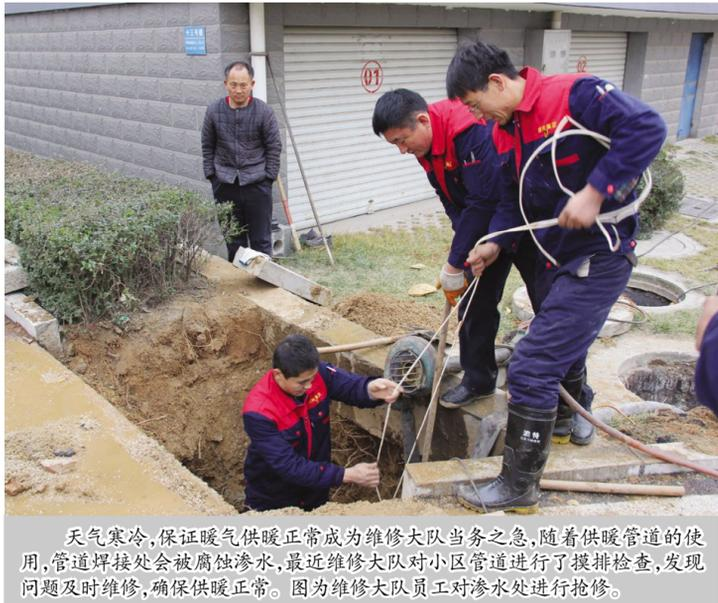
天气寒冷，保证暖气供暖正常成为维修大队当务之急，随着供暖管道的使用，管道焊接处会被腐蚀渗水，最近维修大队对小区管道进行了摸排检查，发现问题及时维修，确保供暖正常。图为维修大队员工对渗水处进行抢修。
