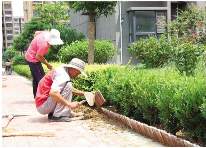
为增加鑫琦福邸绿化的美观,物业利用原敬老院屋顶的红瓦,改造后,对主路上绿化带边裸露的土壤进行遮挡,不仅美观,同时也方便了灌溉。
