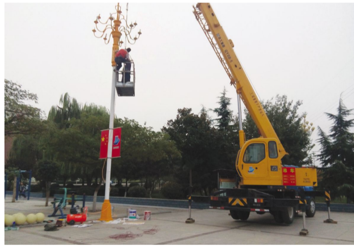
为提升辖区路灯亮化、美化效果,维修队利用三天时间把办公楼前和圣贤广场的高灯重新进行粉刷,并全面整修不亮的路灯及损坏的灯罩。 物业维修公司
